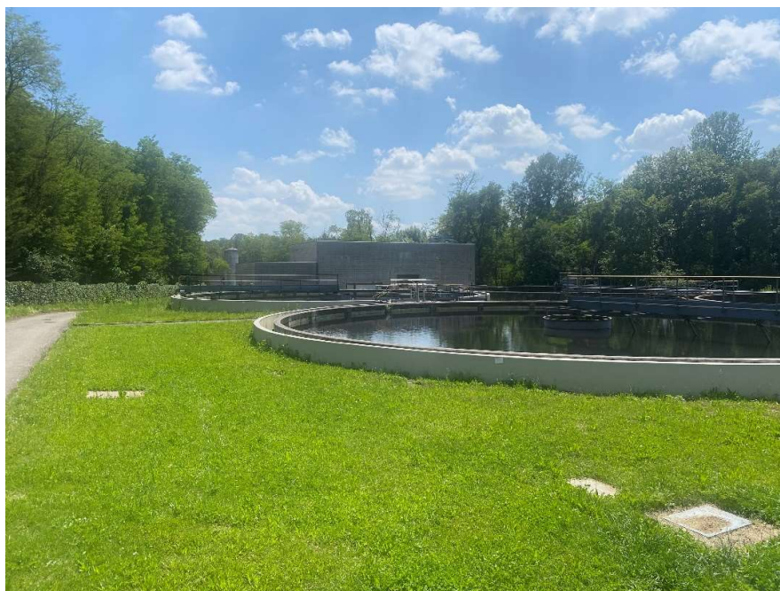
Manutenzione straordinaria opere civili sedimentatori secondari Impianto di depurazione Alto Seveso
